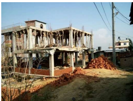
het huis van Suresh in opbouw
